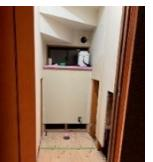
▲トイレを撤去し、床板も張り替え。◀階段下の狭いトイレが快適空間に！
