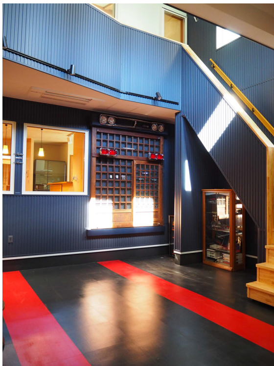
▲収納式階段。使用しないときは収納して車の出し入れの妨げにならない設計。
