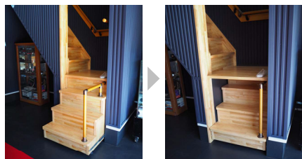
▲収納式階段。使用しないときは収納して車の出し入れの妨げにならない設計。
