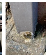
▲柱の根本や霧除けなど、雨水のたまりやすい所は腐食も進みやすいので気を付けましょう。
