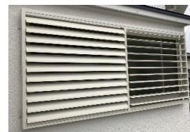
◀羽根の角度は最大130度、コントロールは内側からのみなので、防犯性にも優れています。
