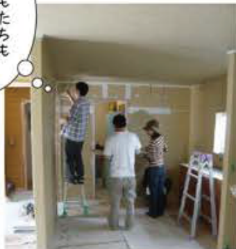
友人達や工事関係者皆で壁塗りをしました。
