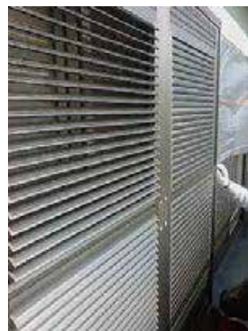
写真は可動ルーバー型雨戸 当社で2月に施工
